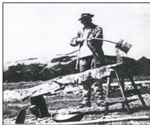
Fig. 8 Recuperarea aurului aluvionar cu ajutorul hurcii pe râul Arieș (România, sfârșitul sec. XIX) (Popescu et al., 2007)
