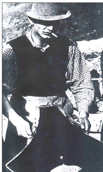
Fig. 6 Concentrarea aurului cu șaitrocul (Mt. Apuseni, sfârșitul secolului XIX) (Popescu et al., 2007)
